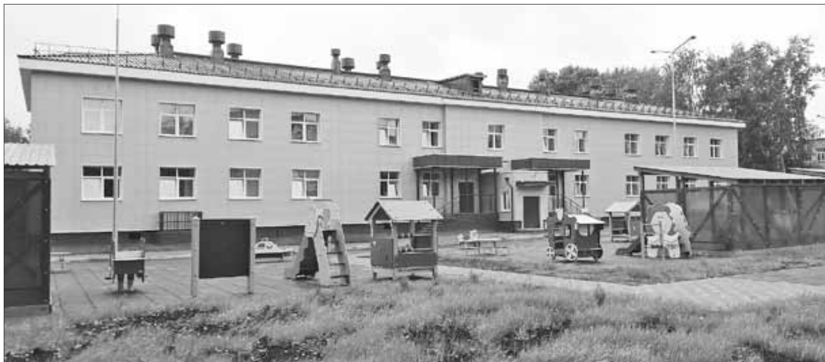
■ Детский сад на 220 мест в округе Варавино-Фактория (ориентир – ул. Воронина, 31, корпус 3). ФОТО: АРХИВ РЕДАКЦИИ
